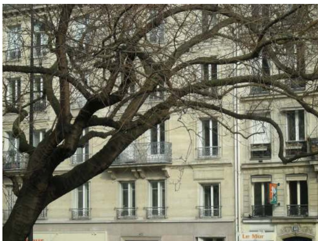
FIG. 10. 50 rue des Écoles
